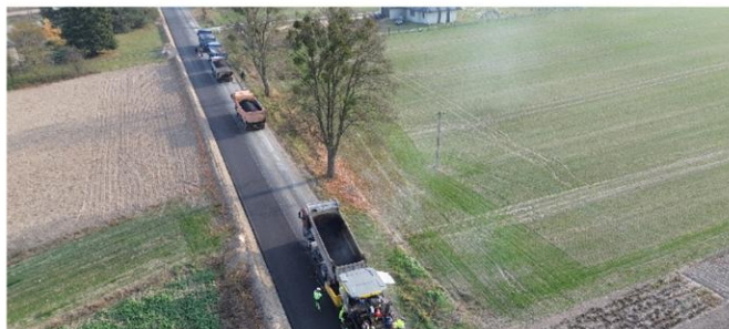
Przebudowa drogi powiatowej w Woli Korybutowej Drugiej, gmina Siedliszcze
