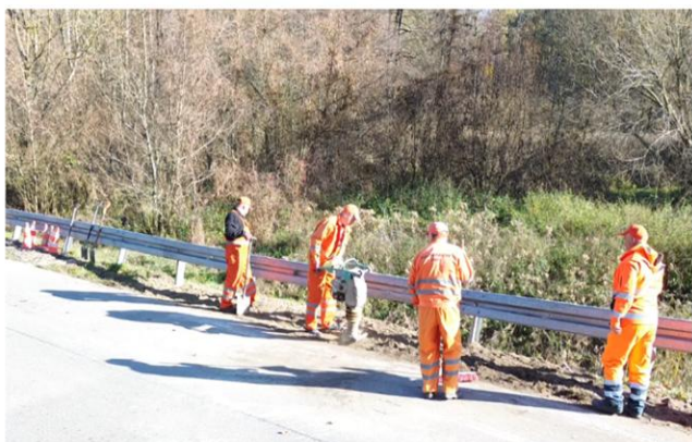
Prace remontowe na moście w miejscowości Chutcze, gmina Sawin
